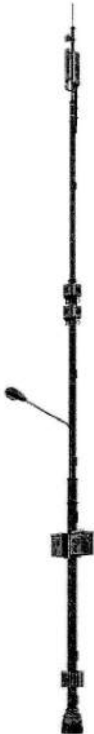
МФО 30 м с размещением оборудования 1 оператора
