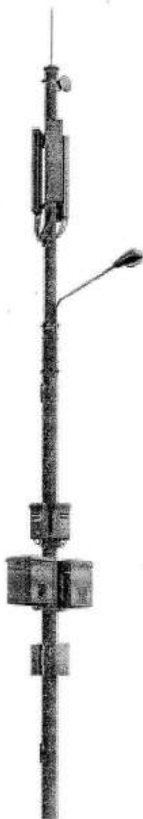
МФО 16 м с размещением оборудования 1 оператора
