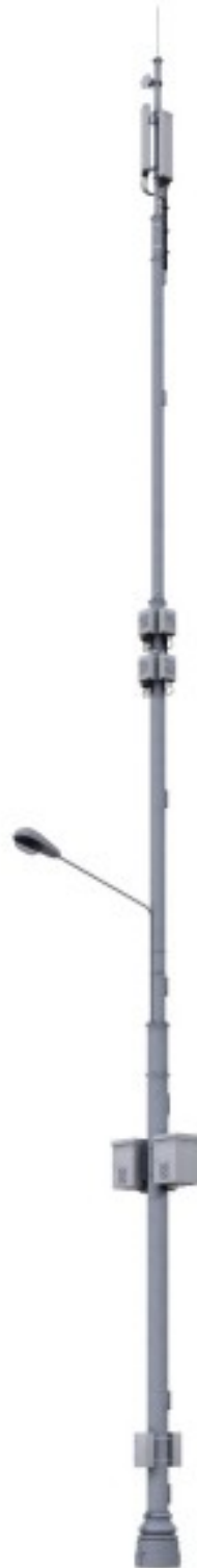
МФО 30 м с размещением оборудования 1 оператора
