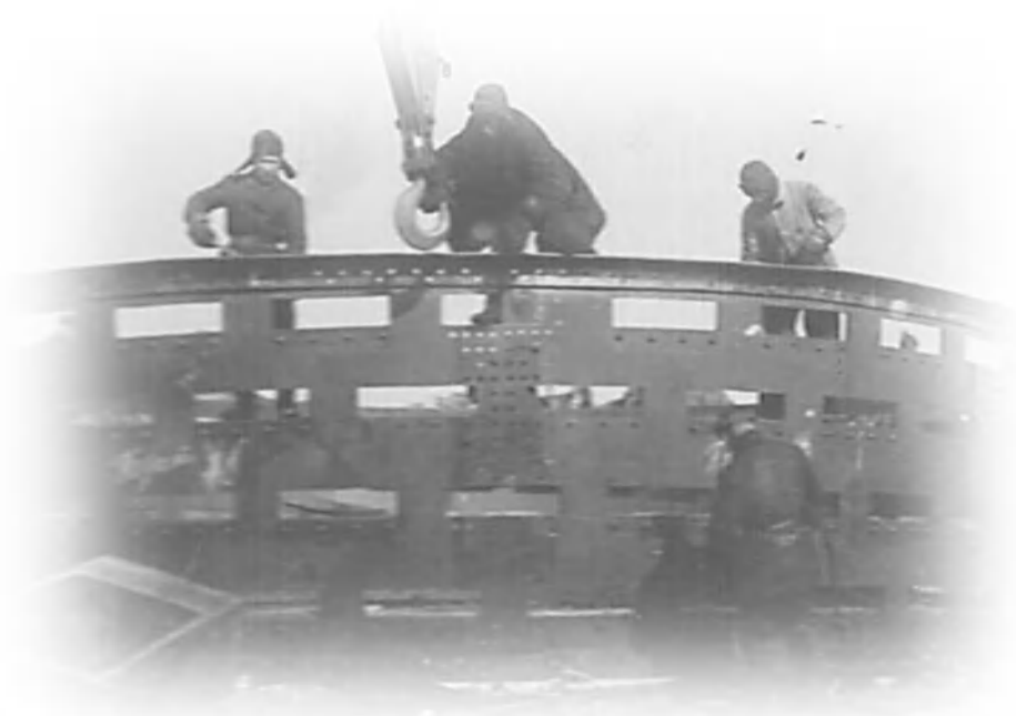
Строительство доменной печи № 1, 1931 г.
